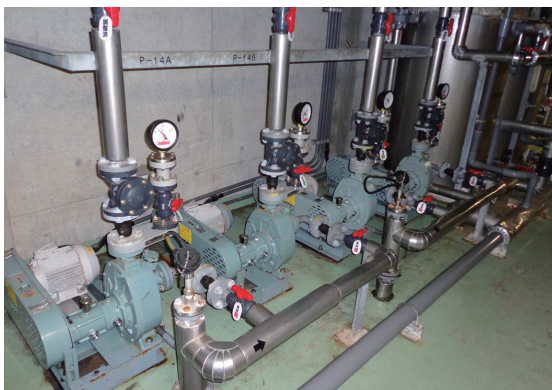
水族館設備（海水移送） Aquarium facilities (sea water transport)
