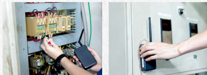
RANDX-C: クランプで配電盤から直接電流計測し、本体は磁石でボックスに吸着
